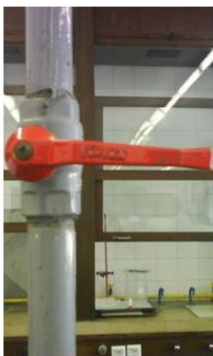
Slika 1. ZATVOREN PLINSKI VENTIL – ventil je OKOMIT na plinsku cijev
